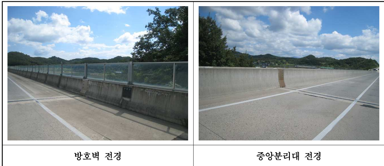
【사진 21.3.48】 방호벽 및 중앙분리대 전경
