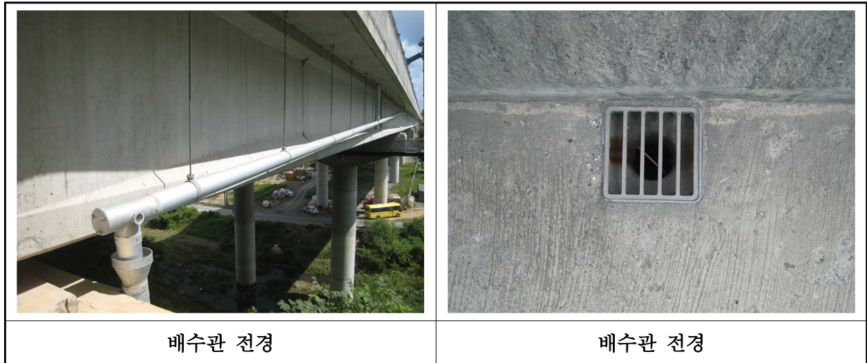
【사진 21.3.46】 배수시설 전경
