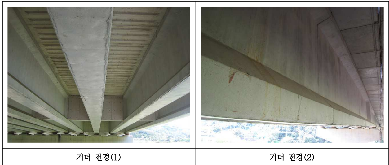
【사진 21.3.29】 거더 전경
