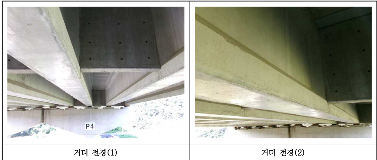
【사진 21.3.4】 거더 전경
