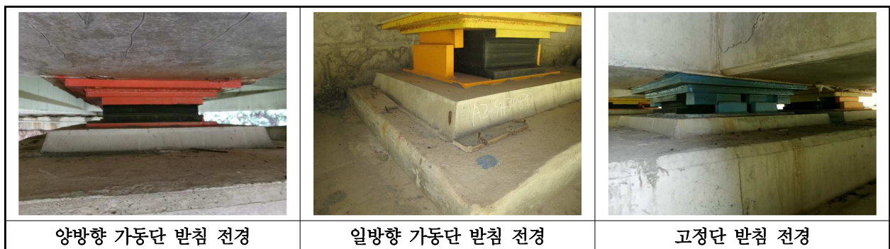
【사진 21.3.12】 교량받침 전경
