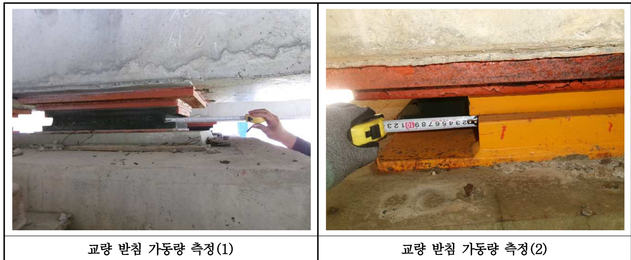
【사진 21.3.15】 교량받침 이동량 측정
