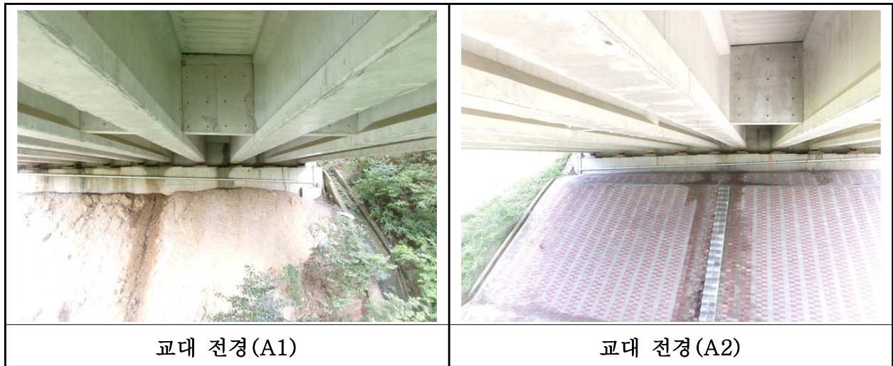
【사진 21.3.8】 교대 전경
