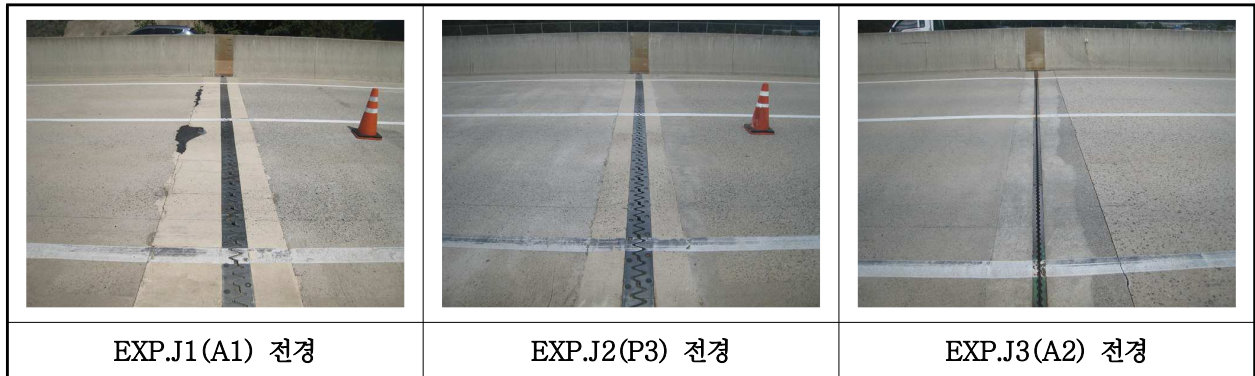
【사진 21.3.41】 신축이음장치 전경
