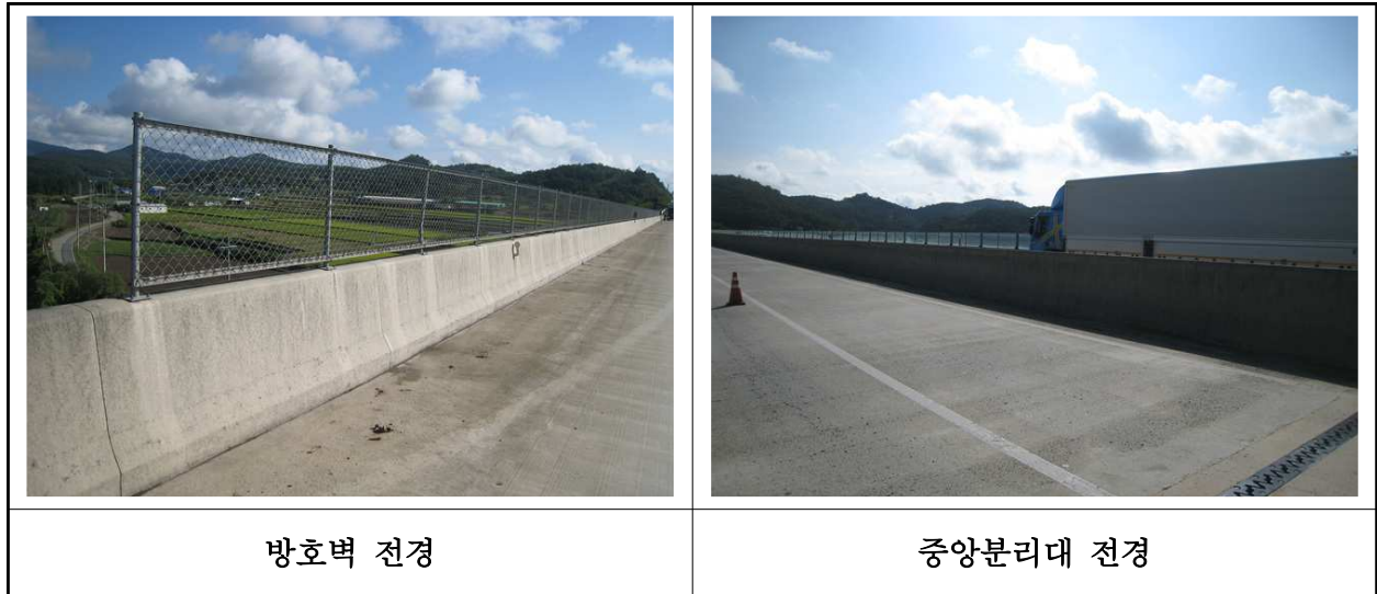
【사진 21.3.23】 방호벽 및 중앙분리대 전경
