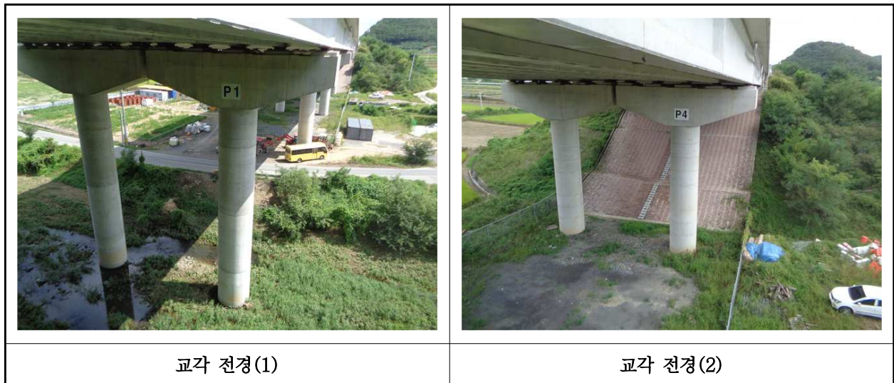
【사진 21.3.35】 교각 전경
