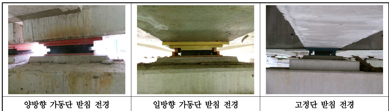
【사진 21.3.37】 교량받침 전경
