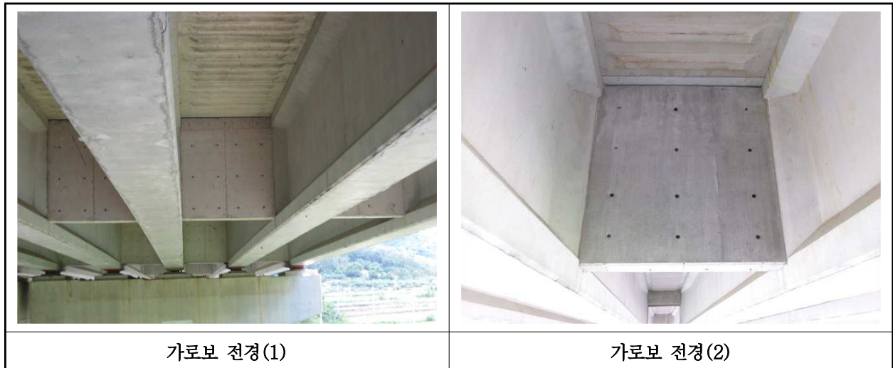
【사진 31.3.31】 가로보 전경
