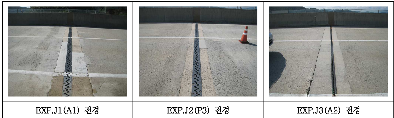
【사진 21.3.16】 신축이음장치 전경
